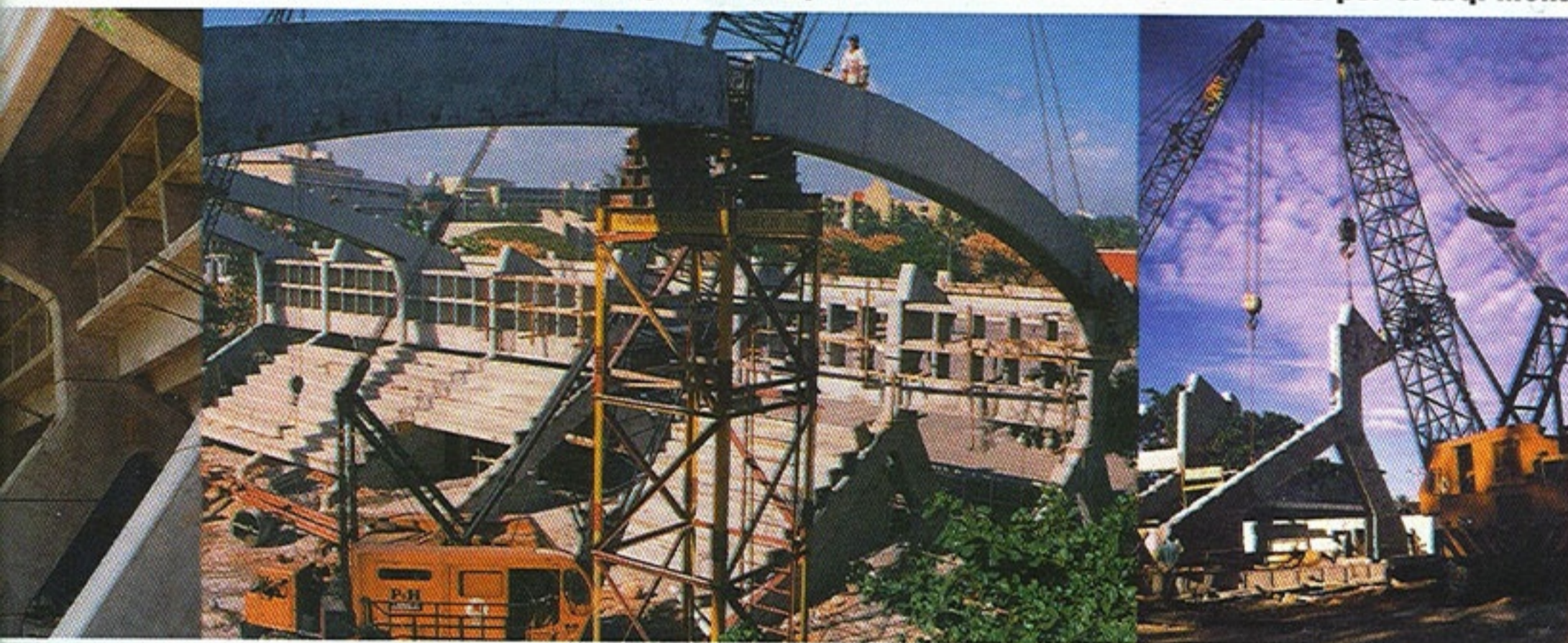
Fotografías del proceso constructivo suministradas por el arq. Mella
