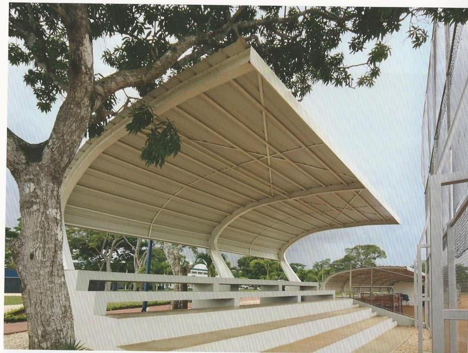
La foto superior muestra la cubierta de las graderías, una estructura metálica cuya curvatura le da gran ligereza.
